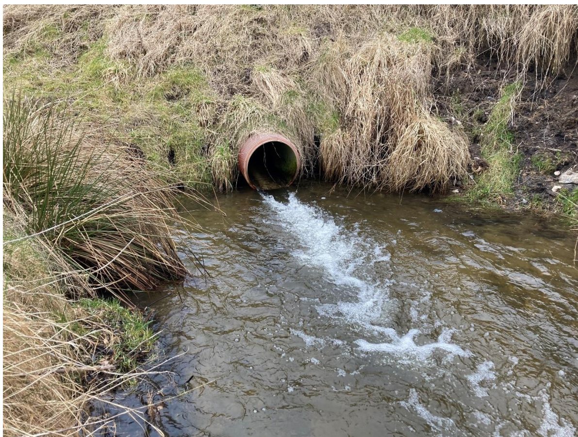
Figur 26. De to vandløb ligger et stykke under terræn efter rørføringerne under den gamle jernbane.
